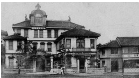
明治38年に建てられた仙台ホテルの建物。昭和20年の仙台空襲で焼失するまで、仙台駅前の顔として親しまれた
