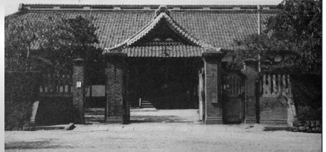
明治時代から昭和初期にかけて使われた仙台市役所(「仙台名勝写真帖」より)
