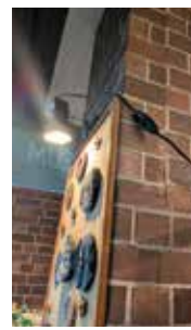
天井のダクトレールにコンセントを設置し、 線を什器に隠わせて目立たないようにした
