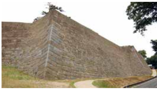
解体修理後の仙台城本丸跡北壁石垣 写真提供：仙台市教育委員会
