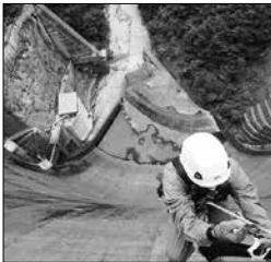
鳴子ダムでの点検作業の様子。 ダムの高さは94.5mにも及び。
