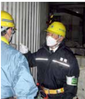
東北発電工業の酒田支社で、発電設備を巡視した際の様子。巡視では、工事の進捗状況や安全品質対策の状況などを確認している。
