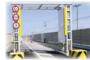
据置型放射線検知装置 東日本大震災以降、コンテナ表面の放射線量測定を継続しており、現在はゲート前付近に設置した本装置で測定しています。(2020年3月完成)
