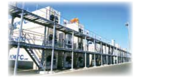
冷凍電源設備 温度管理が必要な農林水産物等の貨物も数多く扱うことができます。(2018年7月完成)
