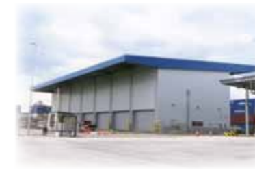
多目的置場 (CFS等) LCL貨物の搬出入や税関検査など、コンテナターミナルには欠かせない様々な機能を備えています。(2020年6月完成)
