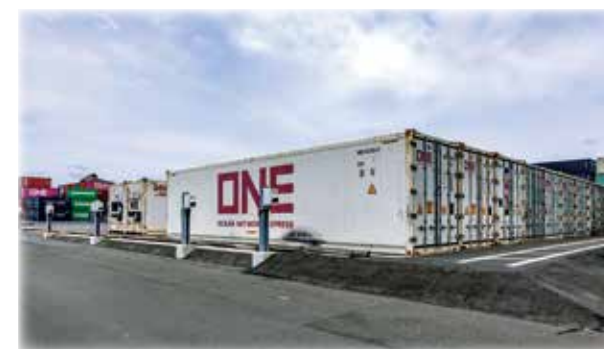
植物検疫検査場 今後の農林水産物の輸出入増加に備えて、植物検疫に対応するための検査場を整備しました。
