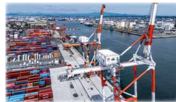
ガントリークレーン3号機 2024年6月に更新を実施し、対応可能なコンテナ列数が16列から18列になるなど機能が拡充されました。
