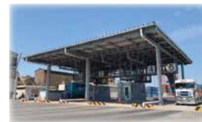
空コンテナ用トラックゲート 増設により、より効率的な空コンテナの搬出入が実現しています。(2023年3月完成)
