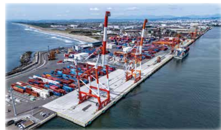
コンテナターミナル全景
