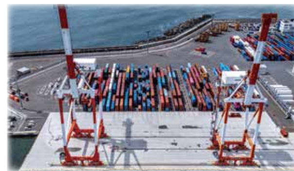
高砂コンテナターミナル第3パース 3号岸壁背後に4haの野積場・荷さばき地を整備し、取扱可能なコンテナ貨物数が増加し、コンテナ貨物取扱の機能向上が図られています。
